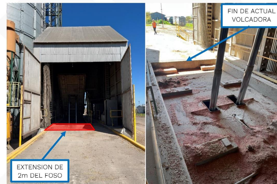
Imagen 10 - Adecuaciones civiles de hormigón para nueva media volcable de 11m
